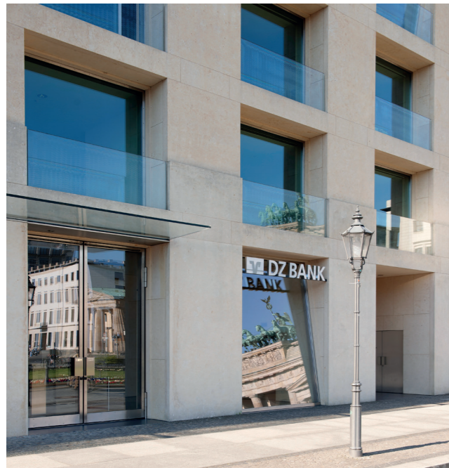
Büro des DGRV im DZ Bank-Gebäude in Berlin
